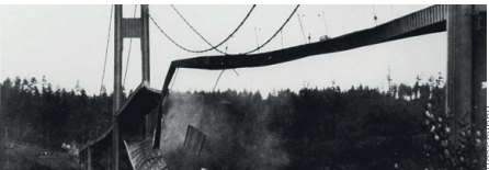
Fig 2.85 Resonancia puente de Tacoma Narrows.
