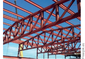
Fig 4.30 Cerchas de una estructura.
