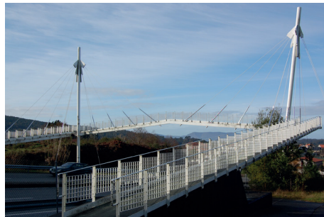
Fig 4.72 Puente peatonal colgante por medio de tensores.
