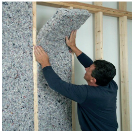
Fig 2.88 Trabajo de insonorización.
