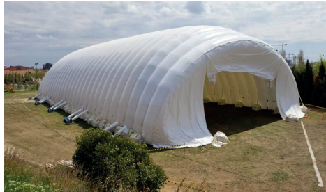
Fig 4.74 Estructura tipo inflable, como estructura neumática.
