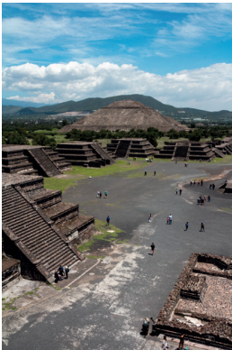
Fig 4.65 Las construcciones históricas por lo general son estructuras masivas.
