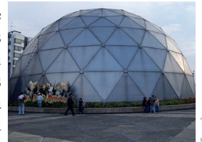
Fig 4.75 Estructura esférica sin necesidad de columnas o pilares.
