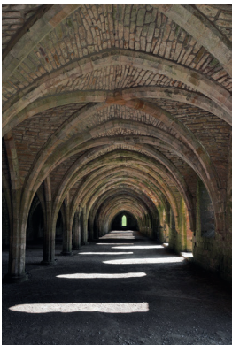
Fig 4.67 Construcciones con arcos para aprovechar el espacio.
