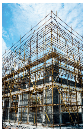
Fig 4.1 Estructura en construcción.
